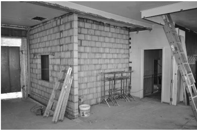
Neuer Saaleingang und Erweiterung Küche
