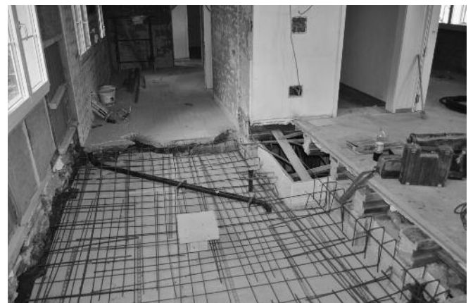
Die Erweiterung der Küche im Rohbau
