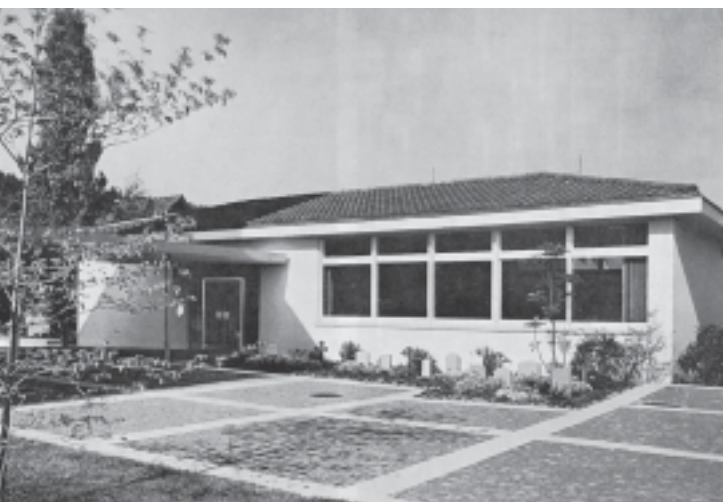
Das Heinrich-Zürcher-Haus muss umgebaut werden.
