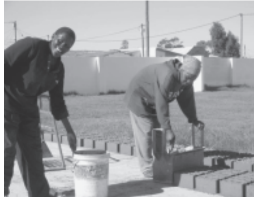
Betonsteine werden von Hand angefertigt.
