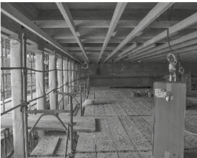
Aktuell erfolgt die Montage der Holzsparen für die heruntergehängten Holzdecke in der Lehrschwimmhalle
