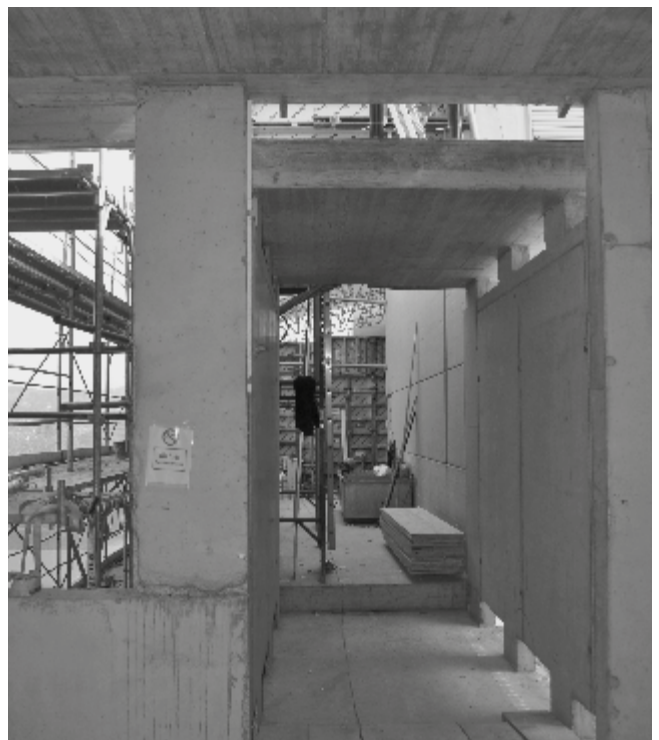
Verbindungsgang von der Erweiterung zum bestehenden Schulhaus
